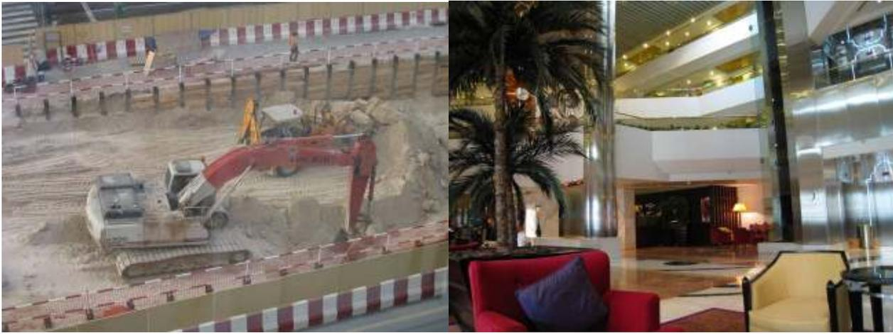
左は滞在したホテル、「ルネッサンスホテル」の前で行われていた地下鉄の工事。街中は全面アスファルトですが、こうして掘り起こしているところは砂漠だったのだと分かります。工事はゆっくり進んでおり、少し掘っては砂が崩れるのを止める作業をしなければならないため、2008年中の地下鉄開通は厳しいのではないかと感じました。
